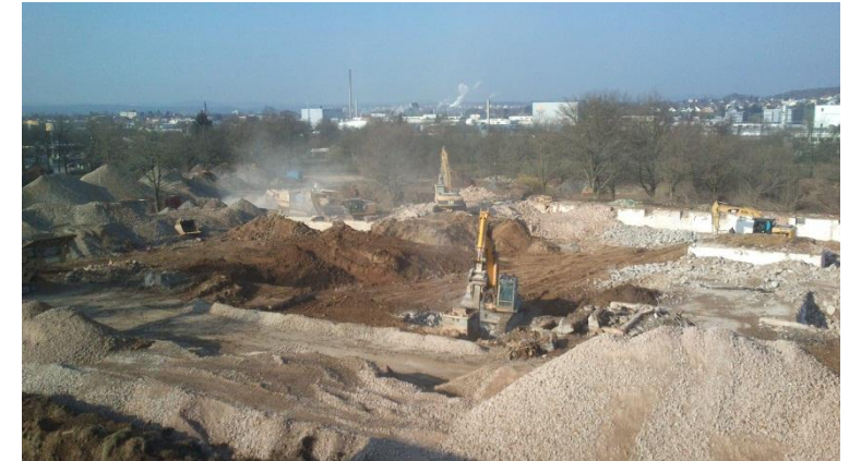
Gebäuderückbau, Geländeprofilierung und Recyclingmaterial
