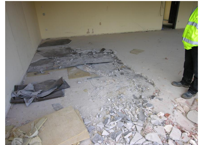
Boden aus Zementestrich
