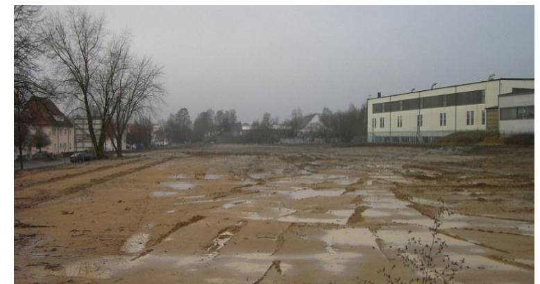
Profiliertes Gelände nach der Sanierung
