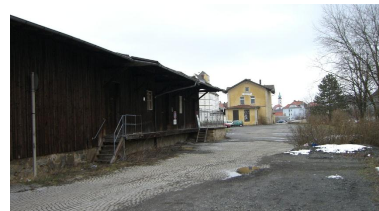
Ehemaliges Bahnhofsgelände vor der Sanierung
