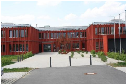
Neubau nach der Sanierung
