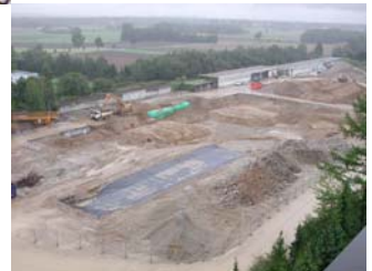
Übersichtsaufnahme während der Bodensanierung
