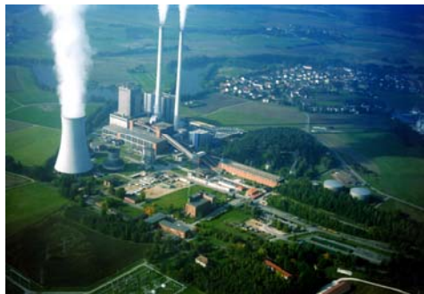
Luftbild des ehemaligen Braunkohlekraftwerks Dachelhofen
