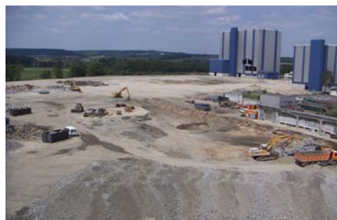
Abschluss der Sanierungsmaßnahmen mit Einbau der güteüberwachten Recyclingbaustoffe
