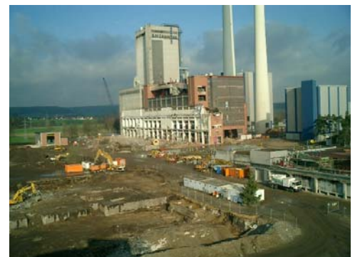
Sanierung des ehemaligen Betriebsgeländes
