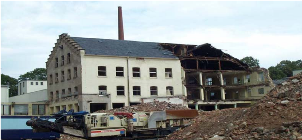
Abbruch von Gebäuden und Brennöfen mit mobiler Bauschuttaufbereitung
